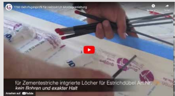
Verlegeanleitung Dehnfugenprofil T8® PRO
